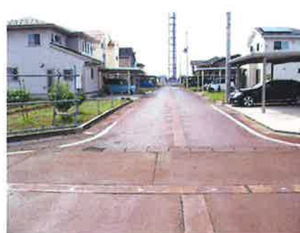
東側から西側に向けて撮影 この道路は分譲地内にある 幅 6.00m の道路です。
